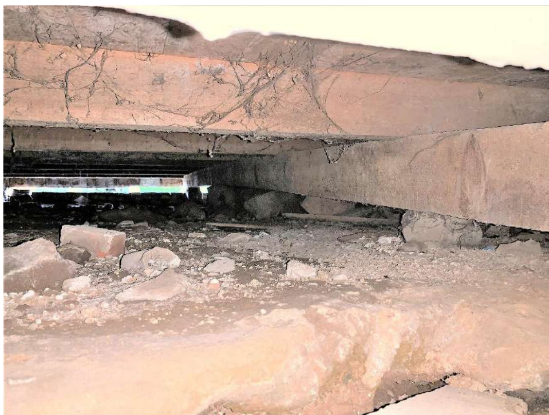
Imagem 6 – Recalque da viga (2021). Fonte: Autores
