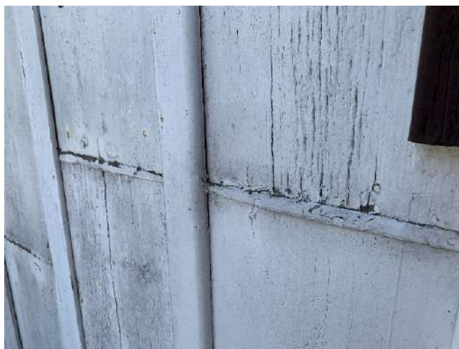
Imagem 17 e 18 – Junção das tábuas novas e antigas (2021). Fonte: Autores
