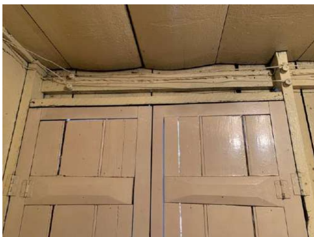
Imagem 30 e 31 – Fiação elétrica aparente no depósito do pavimento superior (2021). Fonte: Autores
