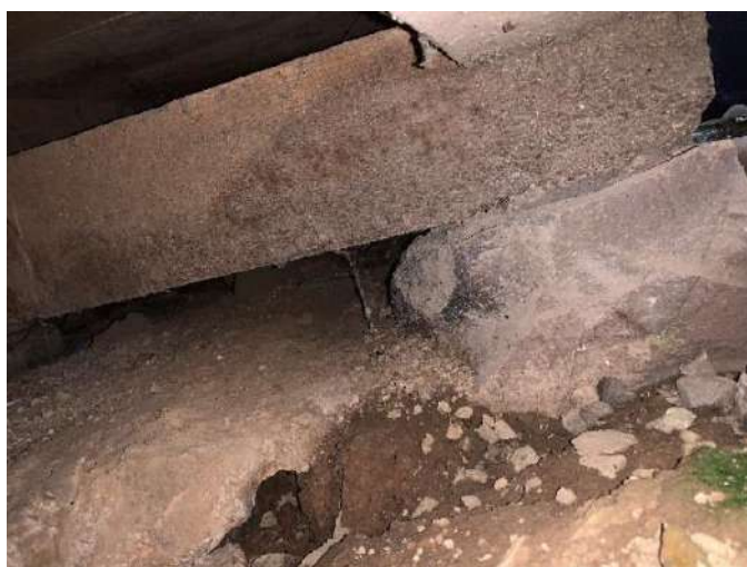
Imagem 5 – Base de pedra onde são apoiadas as vigas (2021). Fonte: Autores
