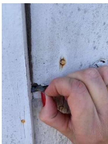
Imagem 17 e 18 – Junção das tábuas novas e antigas (2021). Fonte: Autores
